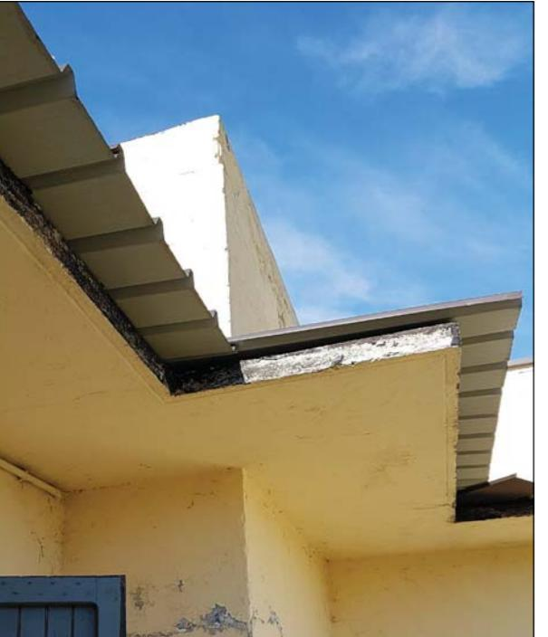
FOTO 16 - DETTAGLIO DELLA VELETTA E DEL MANTO DI COPERTURA INTEGRATIVO IN LAMIERA PREVERNICIATA (RIF. FOTO 5)
