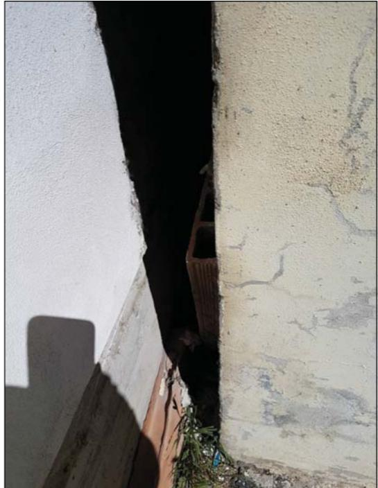
FOTO 22 - GIUNTO DI SEPARAZIONE TRA GARAGE PRIVATO E LA PORZIONE DI PRIMO IMPIANTO DELLA STRUTTURA SPORTIVA (RIF. FOTO 1,2)
