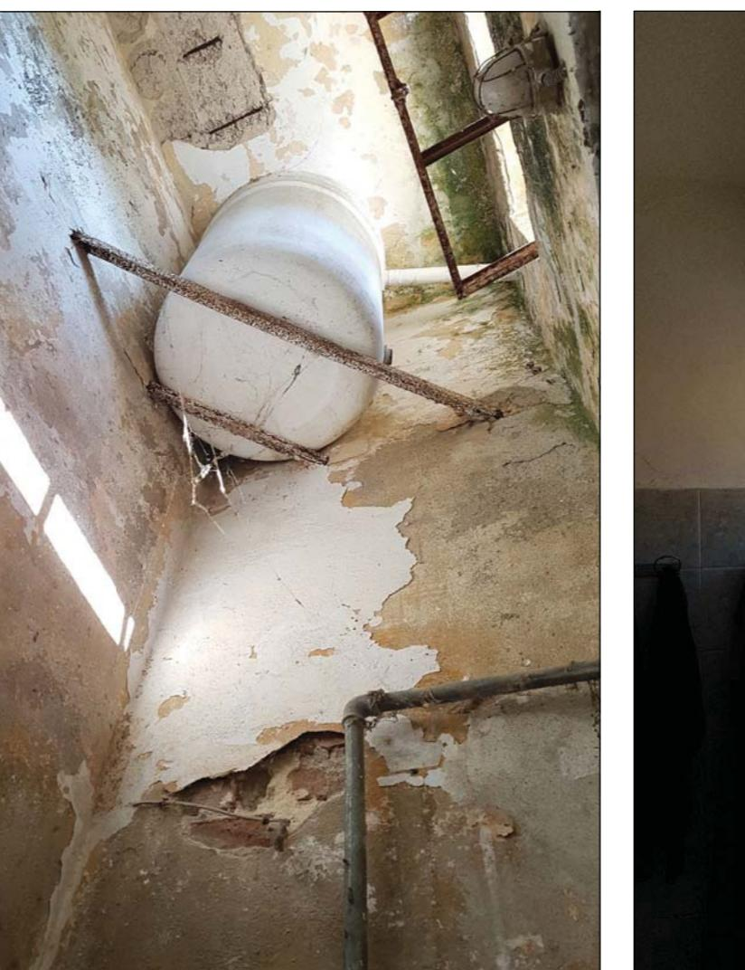
FOTO 26 - DETTAGLIO DEL DEGRADO DEGLI INTONACI DEL PRIMO BLOCCO BAGNI
