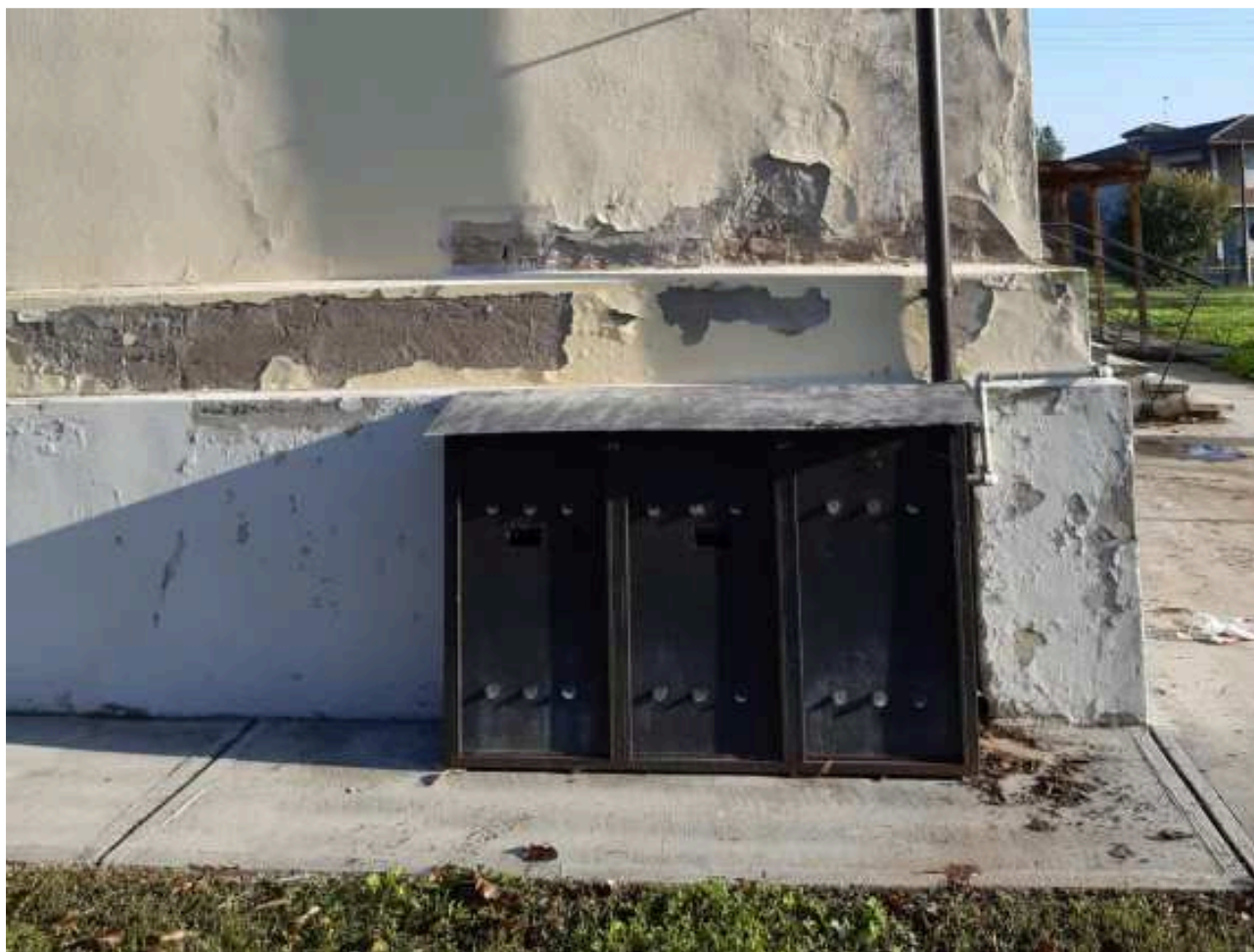
Fig. 6 _ Prospetto sud-ovest _ Si noti che il Sondaggio stratigrafico è stato eseguito nella porzione di intonaco più degradato
